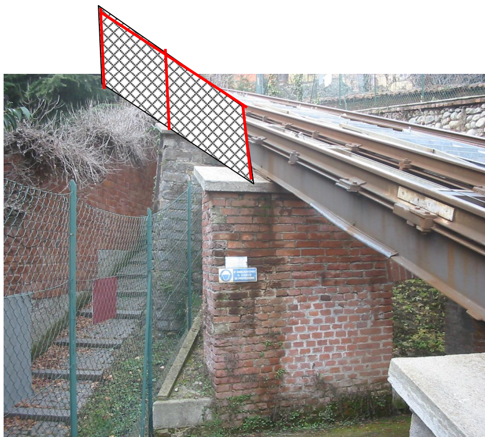
Esempio schematico di applicazione di porzione di rete di protezione
