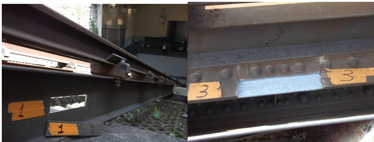
Figura 4: particolare prelievo campioni travi in carpenteria metallica
