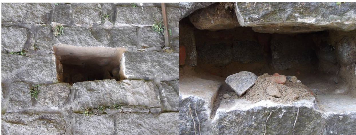
Figura 3: particolare sondaggio pila
