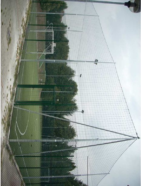
Esempio rete ferma-palloni da calcio su palo rastremato
