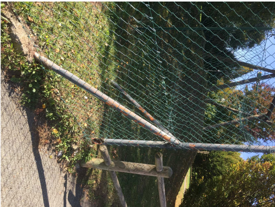
Paletto corroso e distaccato dalla fondazione in cls
