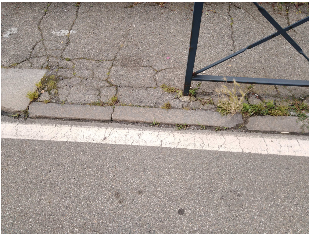
Via Torino: tratto oggetto di futuro rifacimento del piano viabile Si può notare che la mostra del cordolo del marciapiede è praticamente nulla ed ha indotto negli anni ad intervenire con barriere salvapedone per evitare l'invasione dei veicoli sul marciapiede.
